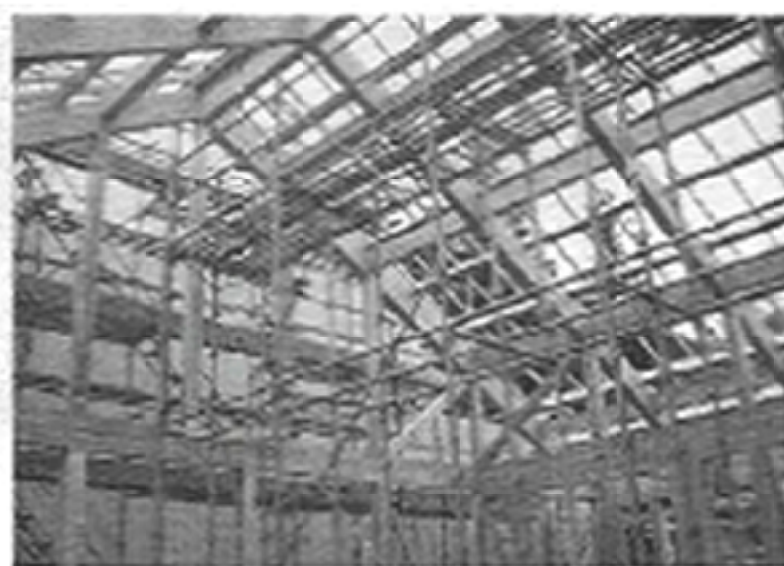
ヘッジ構法で建築中の幼稚園園舎
